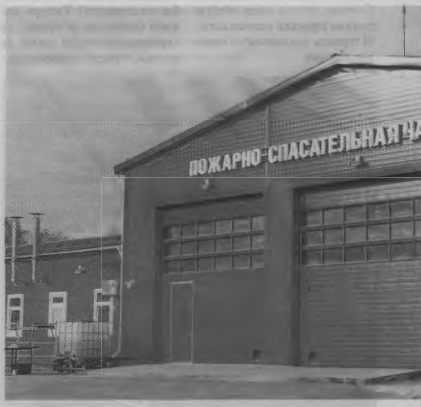
Новое здание пожарно-спасательной части в п. Пижма.
