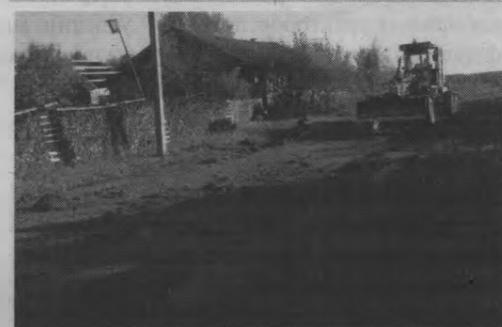
Ведутся работы по содержанию дорог местного значения в деревне Большие Ашкаты. Проводится грейдирование (выравнивание) грунтовых дорог
