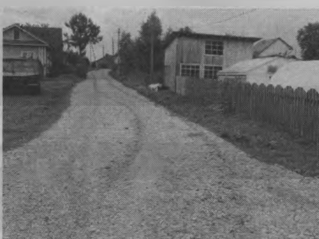
Ремонт автомобильной дороги общего пользования местного значения по ул.Майской в р.п.Тоншаево
