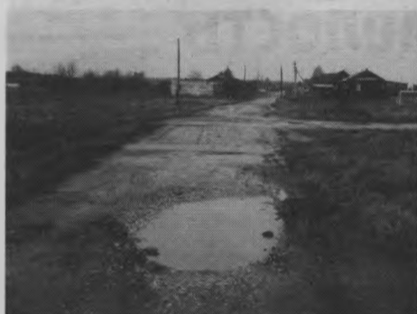
Ремонт автомобильной дороги общего пользования местного значения по ул.Центральной в д.Сухой Овраг
