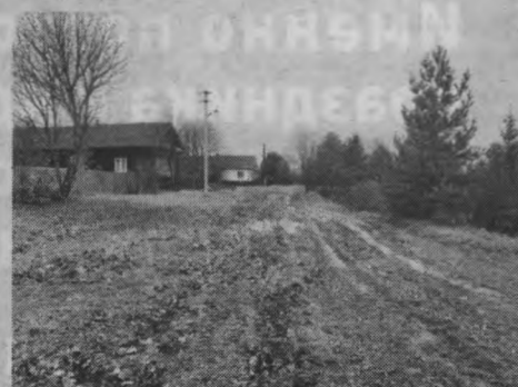
Ремонт автомобильной дороги общего пользования местного значения по ул.Луговой в с.Ошминское
