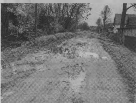
Ремонт автомобильной дороги общего пользования местного значения по ул.Дзержинского в р.п.Пижма
