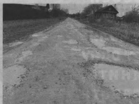
Ремонт автомобильной дороги общего пользования местного значения по ул.Безымянной в р.п.Шайгино
