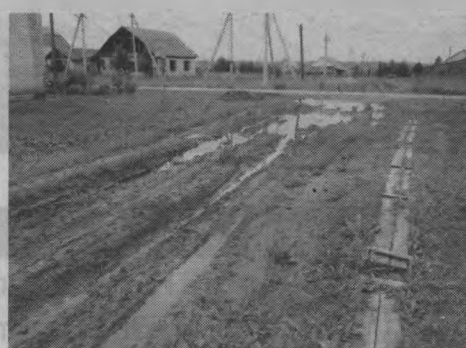
Ремонт автомобильной дороги общего пользования местного значения по ул.Садовой в р.п.Тоншаево
