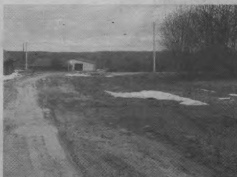
Ремонт автомобильной дороги общего пользования местного значения по ул.Ворошилова в р.п.Тоншаево
