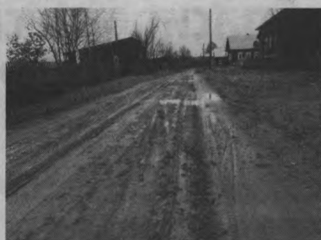
Ремонт участка автомобильной дороги общего пользования местного значения по ул.Заречной в д.Кодочи́ги
