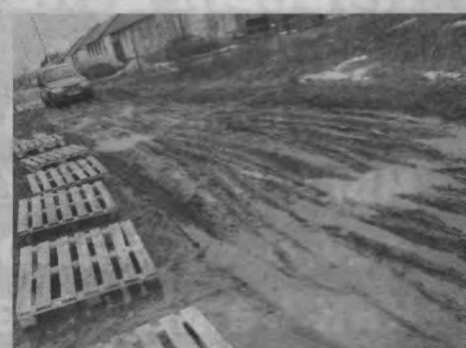
Ремонт автомобильной дороги общего пользования местного значения по ул.Больничной в р.п.Тоншаево
