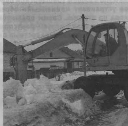
Пришла весна, и на территории Тоншаевского муниципального округа началась активная работа по очистке оголовков водопропускных труб. Очень важно вовремя провести данную работу для сохранности дорожного полотна от действия паводковых вод и предотвращения чрезвычайных ситуаций.
