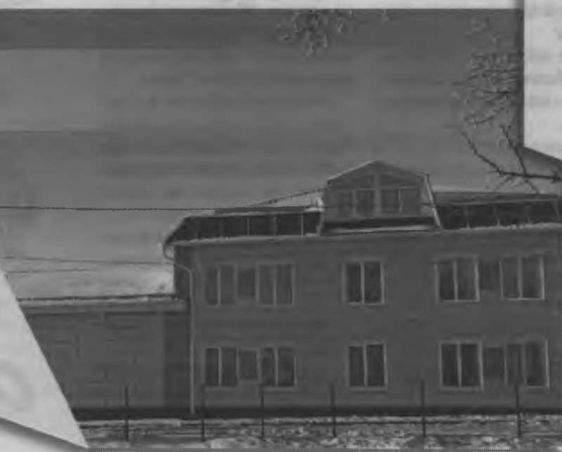
▲ Здание новой музыкальной школы.
