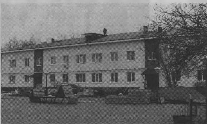
▼ Так выглядит дом на завершающей стадии отделочных работ.
