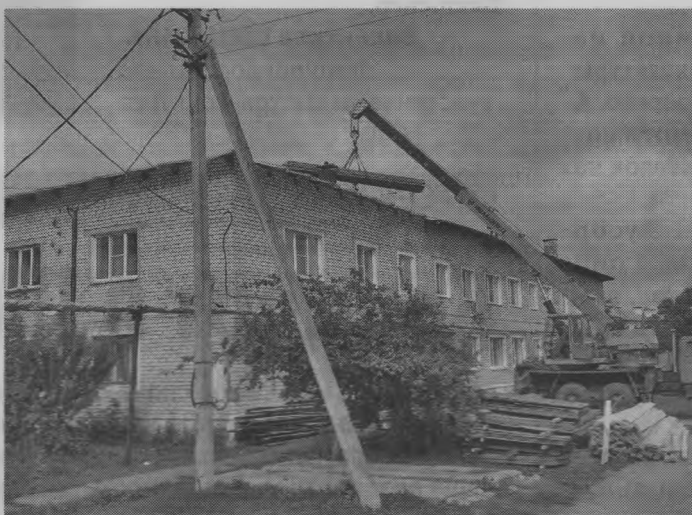
▲ Начало ремонта дома по ул. Королева, 1 в п. Пижма.
