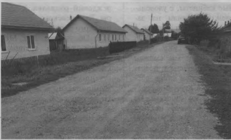
▲ Дорога на улице Новая в п. Пижма будет отремонтирована.
