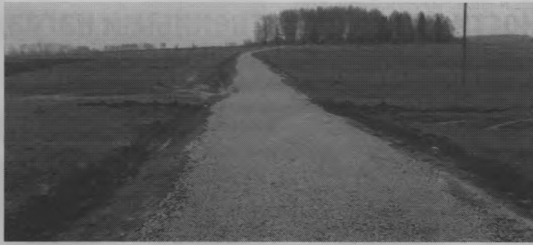
▲ Щебененный участок дороги длиной в 370 метров в д. Б. Селки.
