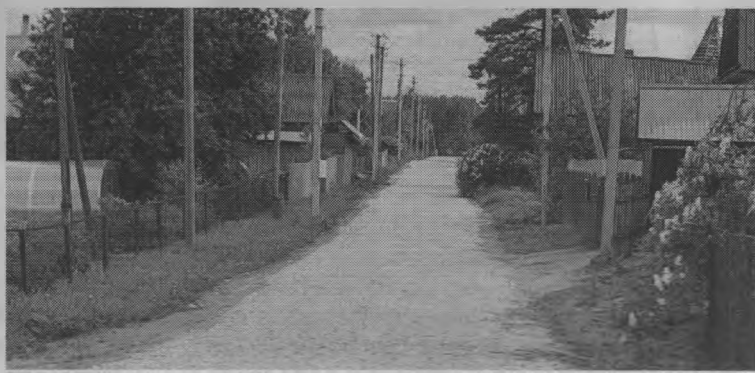
▲ Вот так теперь выглядит улица Запрудная в п. Тоншаево. / Фото предоставлены отделом экономики и развития предпринимательства администрации Тоншаевского округа
