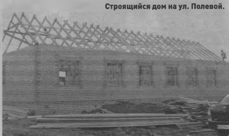
Строящийся дом на ул. Полевой.
