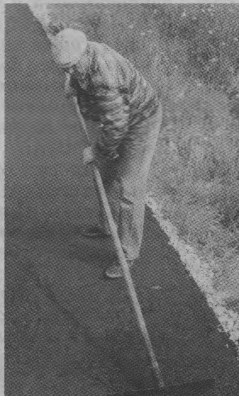
Борис Лачков подравнивает после асфальтоукладчика.
