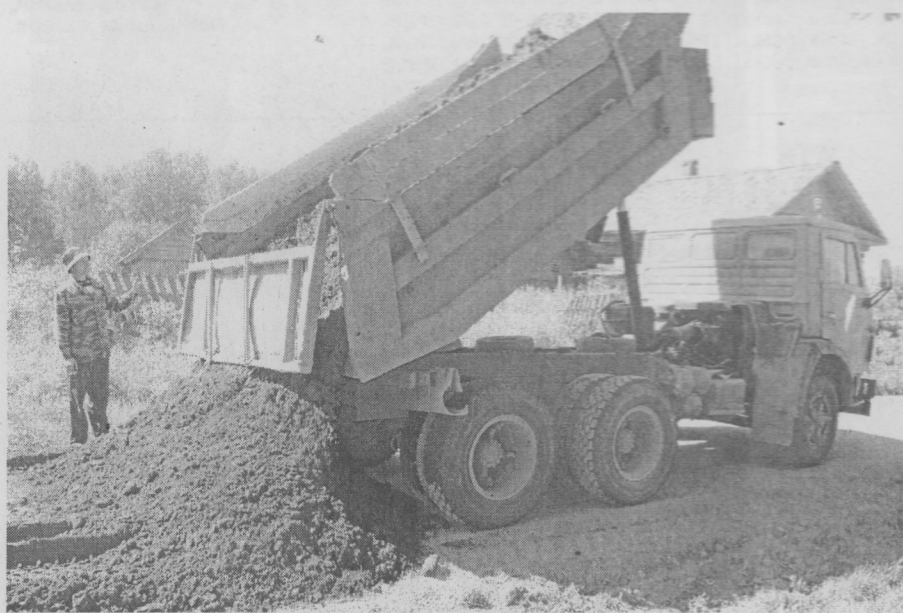
◆ Для укладки песчаного основания.
