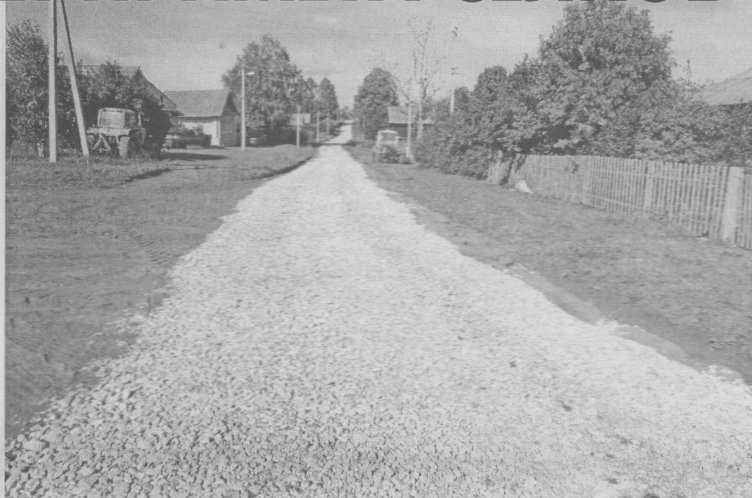
◆ Новая дорога по улице Центральной.
