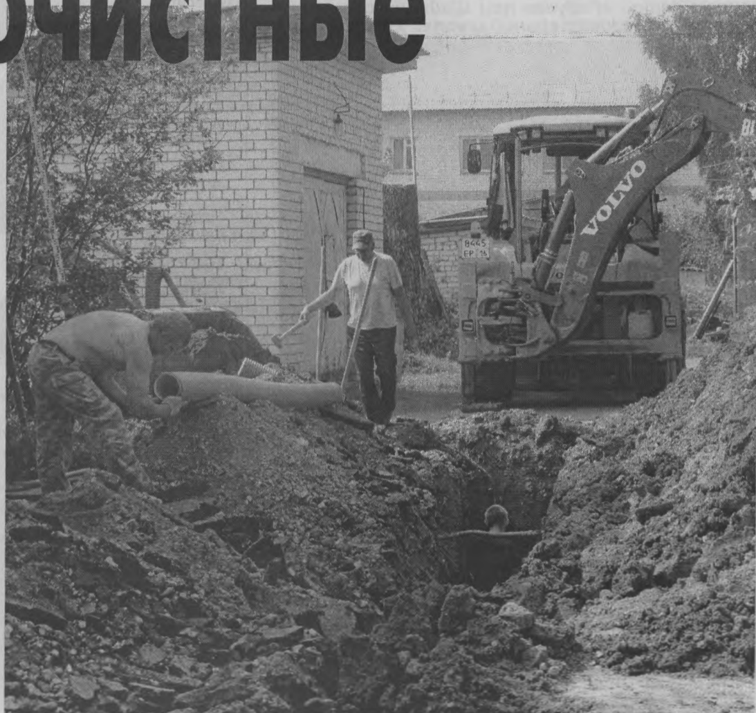
◆ Бригада выполняет подводку.
