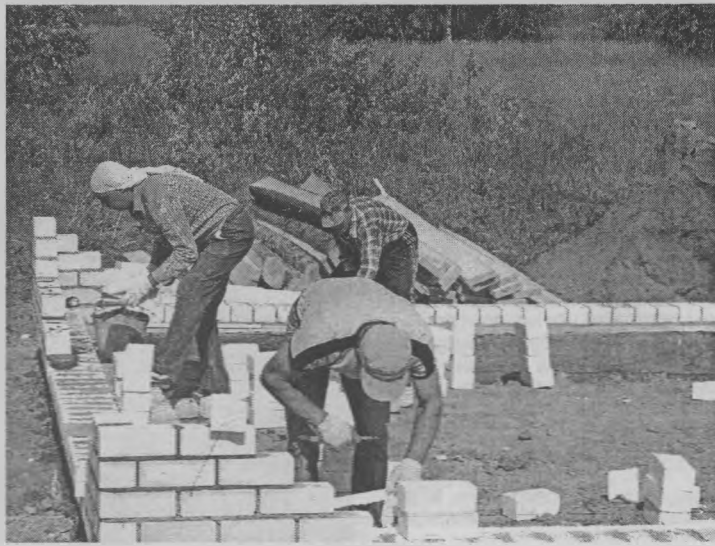
◆ Дом на улице Крупской на начальном этапе строительства...
