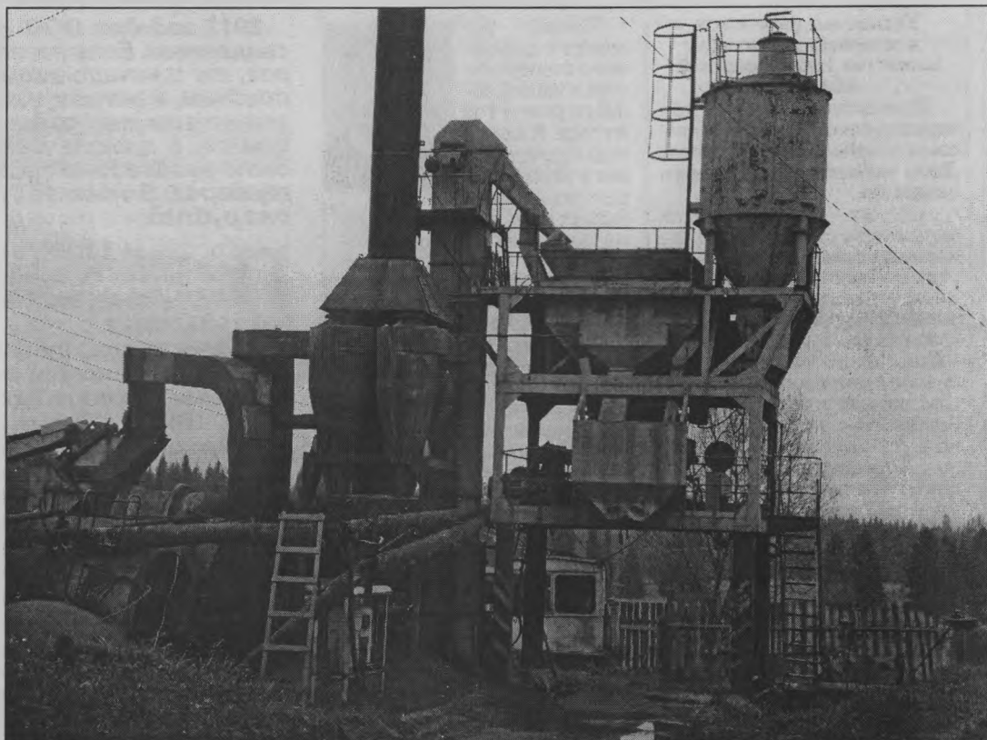
◆ В ООО «Лесное» есть свой асфальтобетонный завод.
