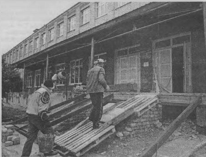
◆ На центральном входе будет новое крыльцо.
