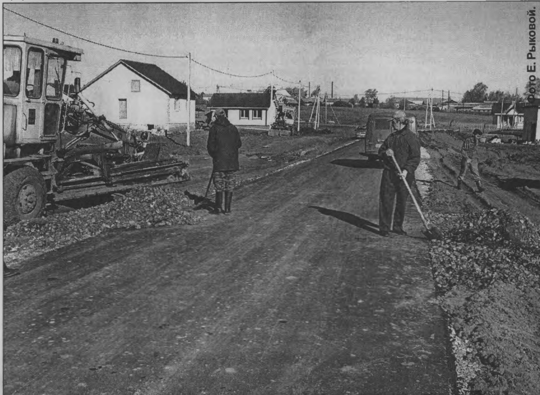
На улице Спортивной, первом Спортивном и втором Спортивном переулках в поселке Тоншаево идет асфальтирование проезжей части дороги.
