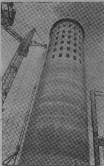
В Новгородском производственном объединении «Азот» закончено сооружение башни грануляции. Ее высота — 117 метров, диаметр составляет 28 метров. Башня возводилась методом скользящей опалубки.
