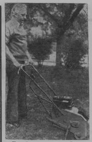
Такой механической лопатой можно делать все те операции, что и обычной, экономя при этом силы и время, как утверждает бельгиец Жюль Дюрье, изобретший эту новинку. Лопата работает как с электрическим, так и с бензиновым мотором.
