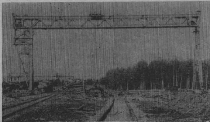
На нижнем складе для разгрузки хлыстов с вагонов МПС, а также с лесовозных машин установлен новый кран ЛТ-62 грузоподъемностью 30 тонн. Фото А. Эргле.
