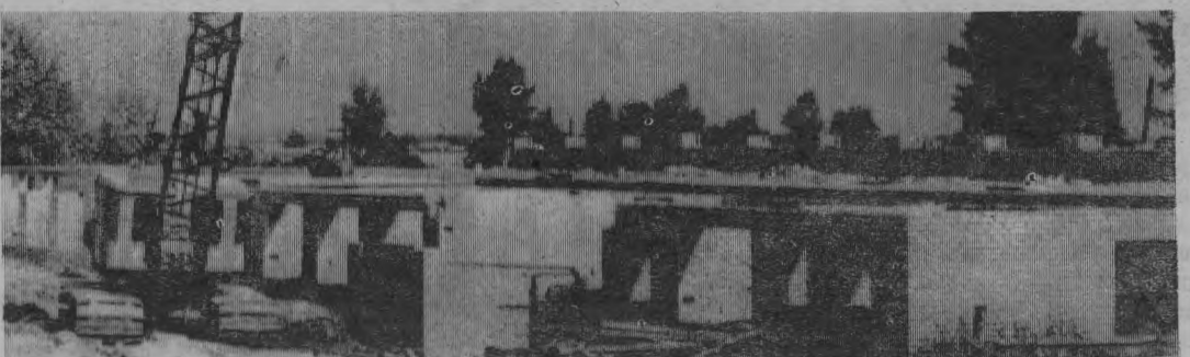
Строится Пижемская участковая больница на 250 мест
