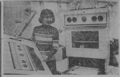
На Московском заводе домашних холодильников сконструирована новая газовая плита. У нее улучшен внешний вид, духовое отделение снабжено подсветкой. Из четырех ее комфорок—одна повышенной мощности, на которой можно вскипятить чайник в полтора раза быстрее. Коэффициент полезного действия плиты составляет 57 процентов. Это на два процента больше, чем установлено
