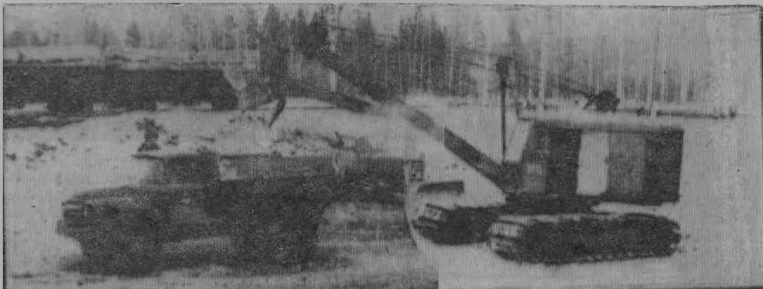
Экскаватор загружает автомашины щебнем.
