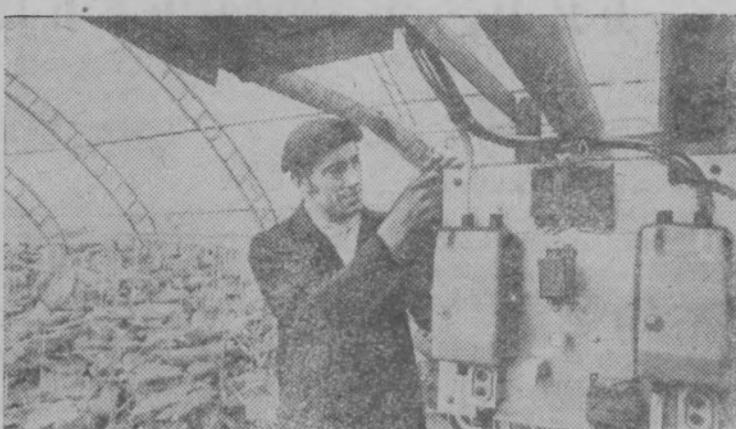
**Московская область.** В овощном совхозе Марфино имеется теплица с пленочным покрытием. Она представляет собой арочную конструкцию, на которой крепится пленка, и имеет автоматическую приточно-вытяжную вентиляцию. Теплицу изготавлили машиностроители города Электростали (Московская область), а автоматику собрали электрики совхоза.
