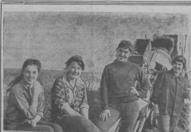
Механизаторы мелиоративных станций Ярославской области превращают сотни гектаров заболоченных земель совхозов и колхозов в отличные пастбища. Большие работы развернуты и в совхозе «Курба», где уже сейчас закрытый дренаж заложен на 120 гектарах заболоченной земли.
