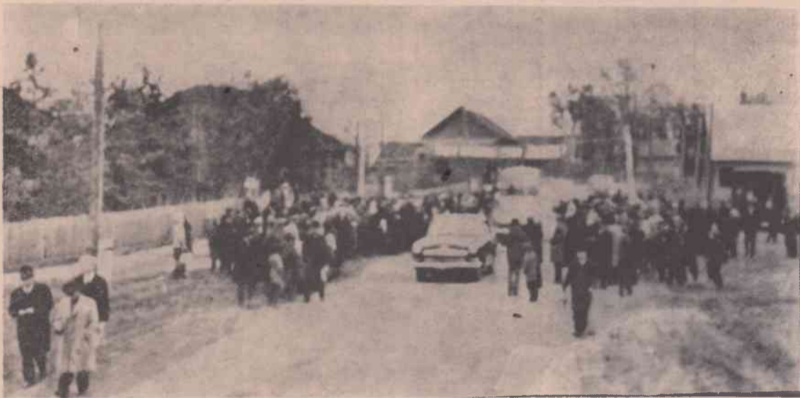
Дорога открыта. По асфальту пошли машины.
