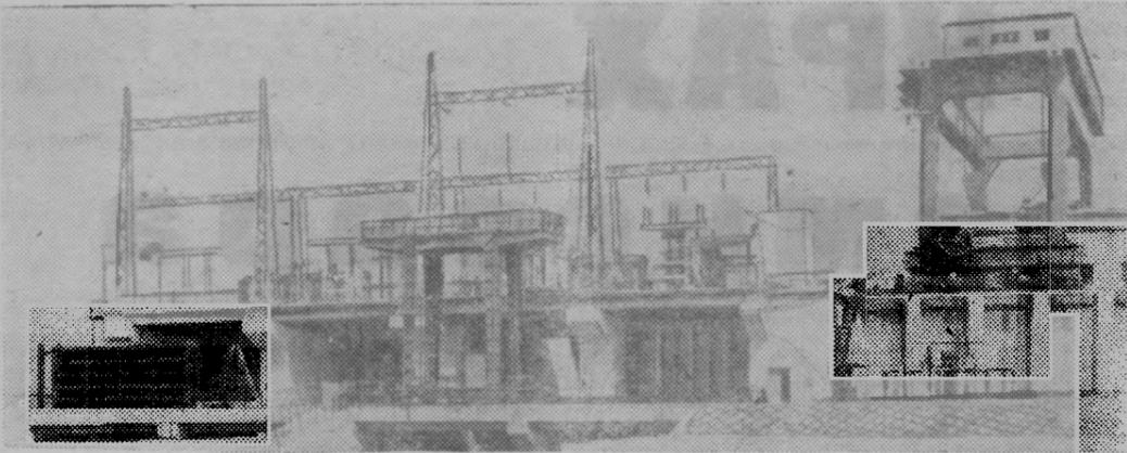
**ВОЛОГОДСКАЯ ОБЛАСТЬ.** Более ста миллионов киловатт-часов электроэнергии выработала уникальная Череповецкая ГЭС за время своей экспериментальной эксплуатации. Здесь проходят всестороннюю проверку первые генераторы с водяным охлаждением и уникальные горизонтальные капсульные турбины.
