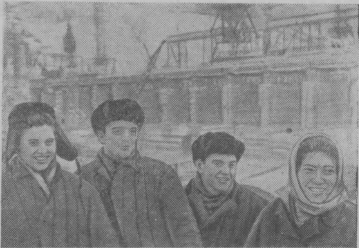
евои Виктор Адамович, плотник-бетонщик Евгений Комаров, рабочая Юлия Лаврова. Внизу — на строительстве Красноярской ГЭС.
