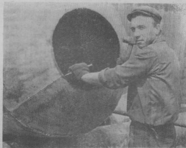
Слесаря первого химического цеха канифольно-экстракционного завода «Вахтан» Александра Ивановича Торопова по праву называют мастером на все руки. Ему по плечу любая работа по ремонту оборудования.
