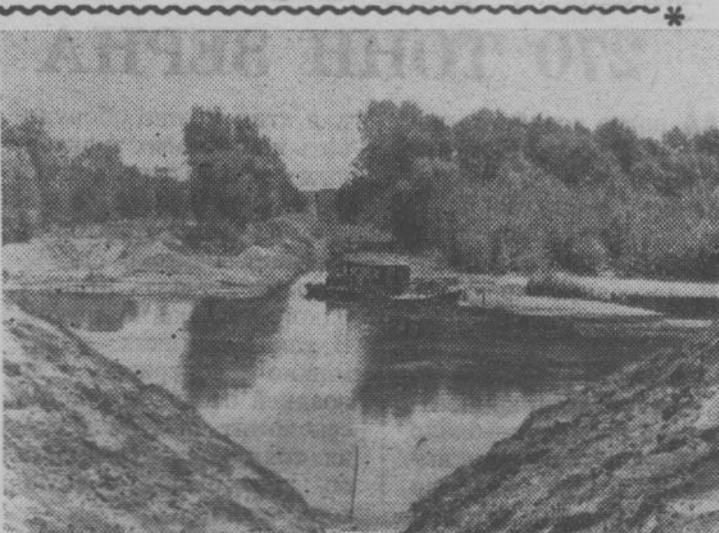
Горячие дни на строительстве газопровода Бухара—Урал. Его трасса вплотную приблизилась к Орске, предприятия которого уже в конце августа получат газ. Строительное управление № 1 треста «Востокнефтепроводмонтаж» готовится к важной операции — прокладке нитки трубопровода по дну реки Урал. На месте, где газопровод пересечет реку, работают водолазы, электросварщики, монтажники, действуют земснаряды.
