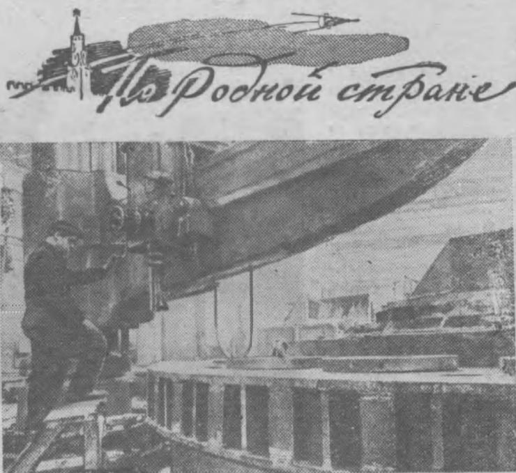
Ленинградская промышленность успешно завершила годовой план. В числе передовых предприятий — Металлический завод имени ХХII съезда КПСС. В истекшем году турбостроители изготовили уникальные машины и оборудование для новостроек. В гидротурбинном цехе идет обработка деталей и сборка узлов восьмой турбины для Братской ГЭС.
