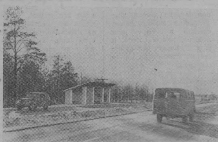
на Горький начинается двумя семиметровыми цементно-бетонными лентами, разделенными зеленой полосой. В ста километрах от Москвы, где меньше напряженность движения транспорта, эта
