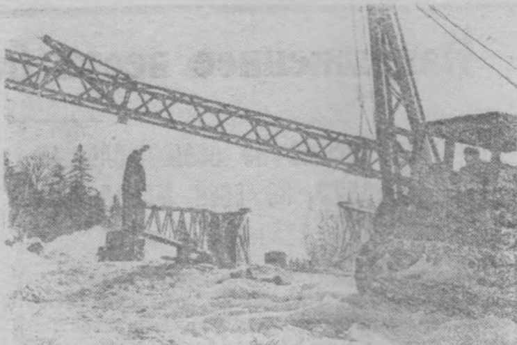
Приморский край. Через тайгу, хребты Сихотэ-Алиня и горные реки прокладывают линию электропередачи монтажники Приморского участка управления «Дальэнерго». Новая линия рассчитана для передачи тока напряжением 220 тысяч вольт на расстояние 355 километров от Суванской ГРЭС до поселка Горелое Тетюхинского района. Она будет питать электроэнергией полиметаллический комбинат «Сихали» и Хрустальненский горнообогатительный комбинат.
