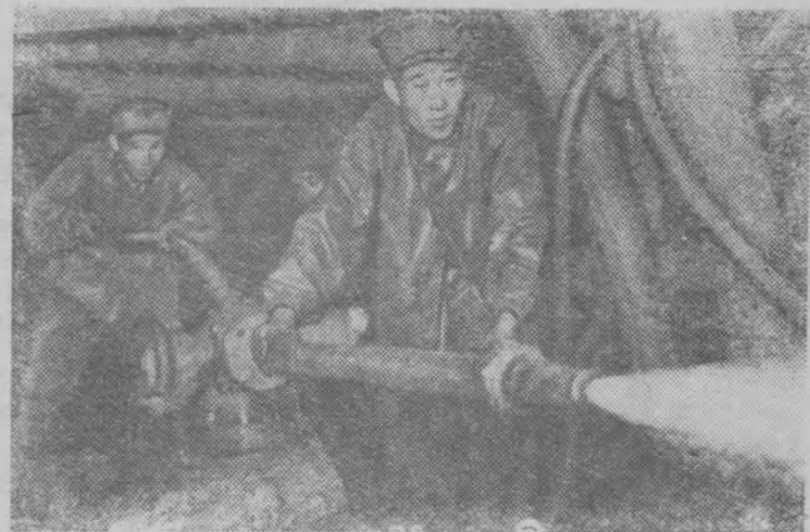
Корейская Народно-Демократическая Республика. На шахте Хенвон в провинции Южный Йхенан добыча угля осуществляется с помощью гидромониторов.
