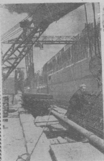
Строительство Воронежской атомной электростанции. Монтаж арматуры.
